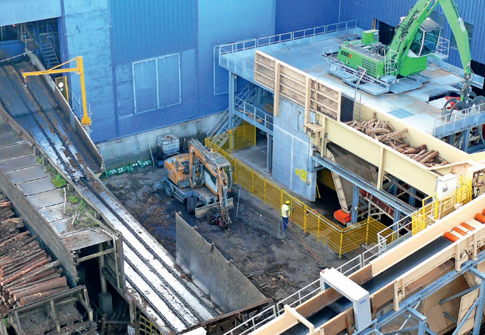
Neuinstallation auf beengten Platzverhältnissen: Die Stämme werden mittels Elektro-Umschlagbagger auf zwei Zerspaner verteilt. Links im Bild die Altanlage: während der Montage musste die Produktion durchgehend aufrechterhalten werden.
